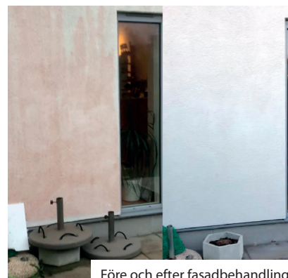
Före och efter fasadbehandling
